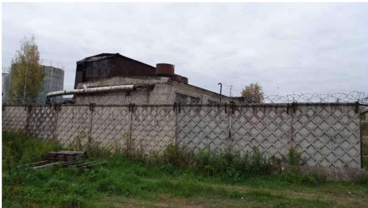
Рисунок 31 Общий вид торцевого фасада здания
