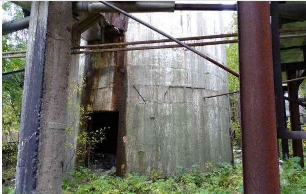
Рисунок 27 Нижняя часть дымовой трубы
