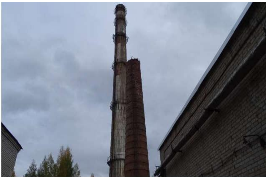
Рисунок 26 Общий вид дымовой трубы
