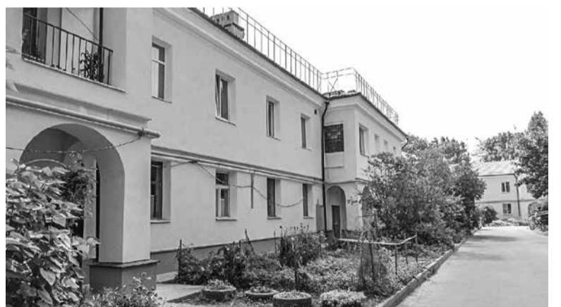
Капитальный ремонт жилых домов по Ленинградскому шоссе
