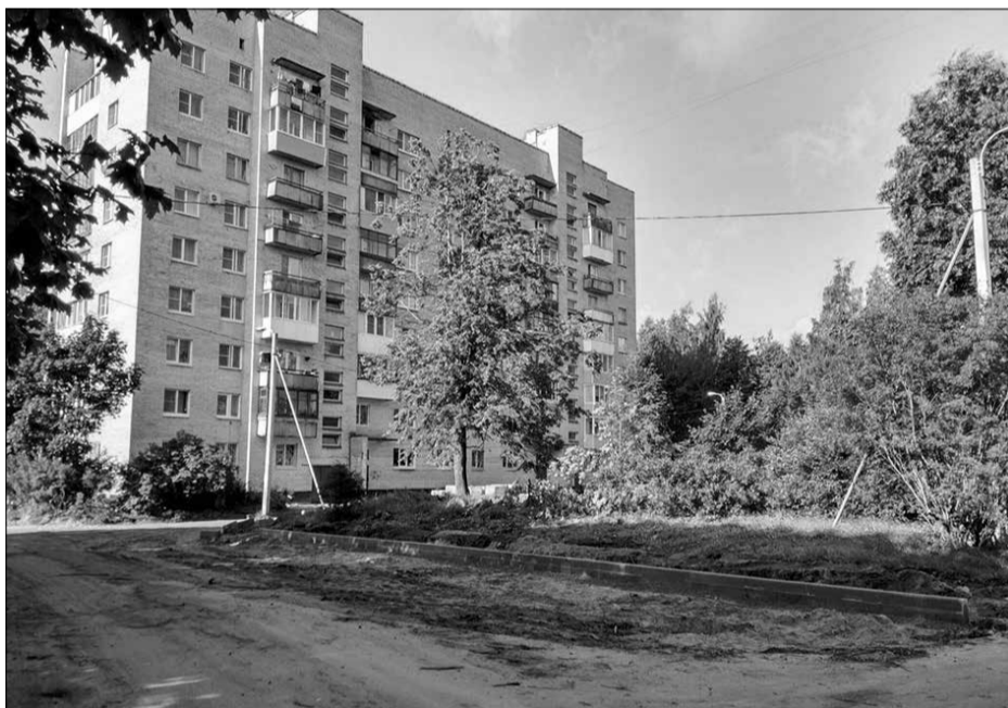
Идут работы на ул. Строителей
