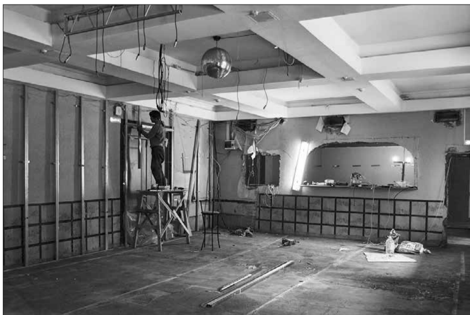
Ремонтные работы в ДК
