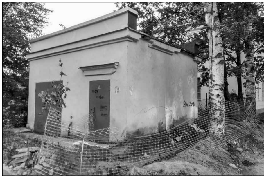
«ЛОЭСК» ведёт модернизацию кабельных линий
